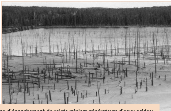
Zone d'épanchement de rejets miniers générateurs d'eaux acides; les rejets proviennent d'une brèche dans une digue qui a cédé.
